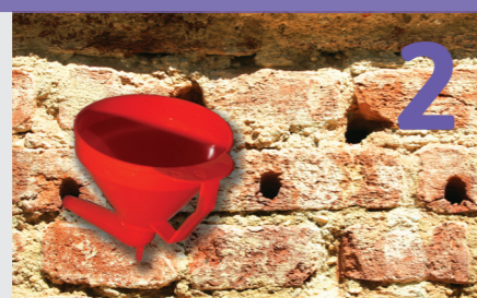
IZVEDBA SILIKONSKE BARIERE
