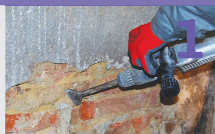
DOLOČITEV VIŠINE IN ODBITJE POŠKODOVANEGA OMETA
